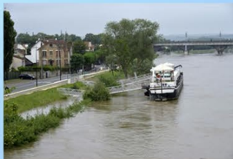
Photo des berges de Sartrouville pendant la crue de juin 2016, la digue est quasiment totalement submergée. Les murettes sont trop en hauteur pour constituer une protection effective contre ce type de crue.
