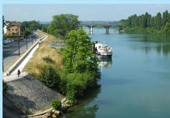
Photo des berges de Sartrouville en temps normal. On y voit très clairement le dispositif anti-crue conçu par la municipalité de Sartrouville : la digue végétalisée et les murettes.
