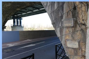
Les murettes et les marqueurs des inondations de 1910 et 1955 se font face sur un pont SNCF dans le cas d'une crue de 1965, le dispositif antioctroi des berges de Sartrouville serait son efficacité, cependant pour une crue de type 1910, le dispositif serait inefficace.
